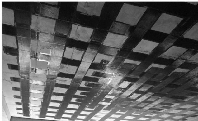
Рисунок. Вид после усиления углеродными лентами.
